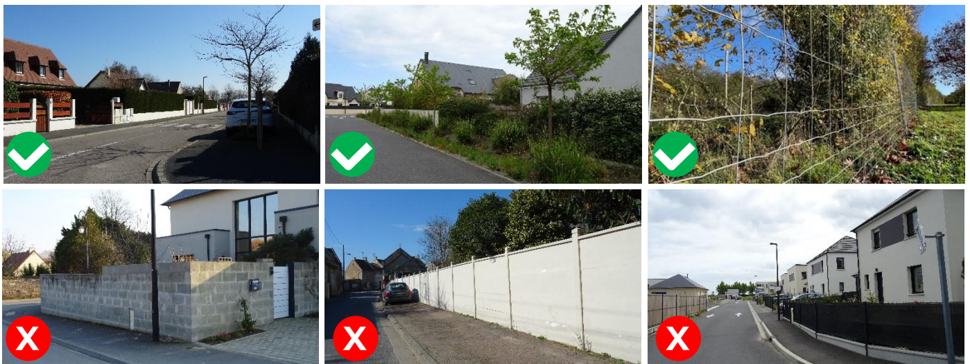
Types de clôtures autorisées et interdites en limite d'emprise publique ou de voie de desserte en zones UA1, UA2, UA3 et UP (source : Géostudio)
